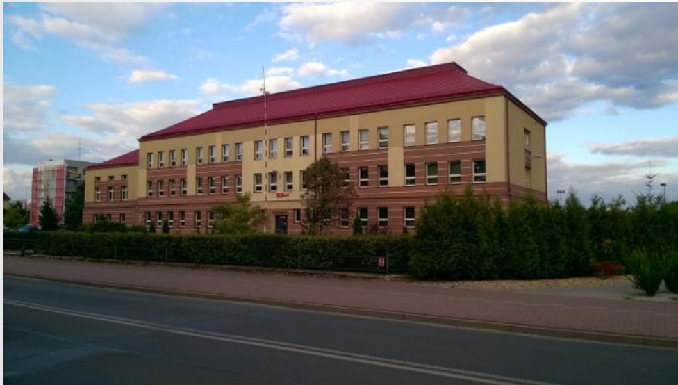
budynek przy ul. Sienkiewicza 8
