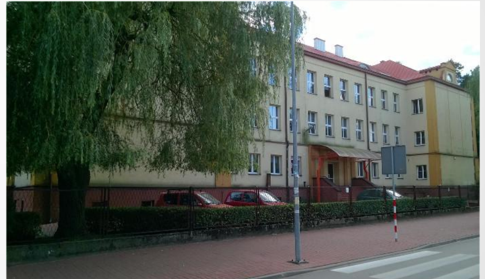
budynek przy ul. Bankowej 13
