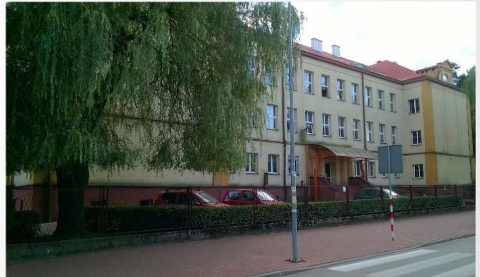
budynek przy ul. Bankowej 13
